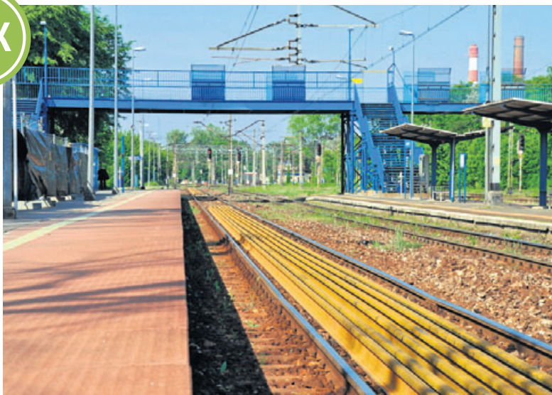
Dzięki modernizacji linii kolejowej do Skawiny podniesie się komfort podróży
