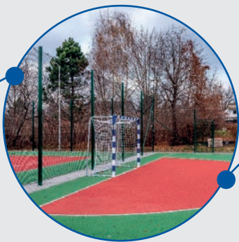
Modernizacja nawierzchni kompleksu boisk sportowych przy ul. 29-go listopada
