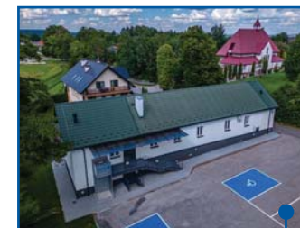
Nowoczesne Centrum Aktywności Kulturalnej w Jaśkowicach
